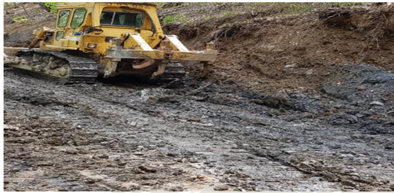
Yol Yapım Çalışmaları
