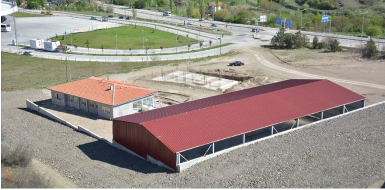
Yangın İlk Müdahale Ekip Binası
