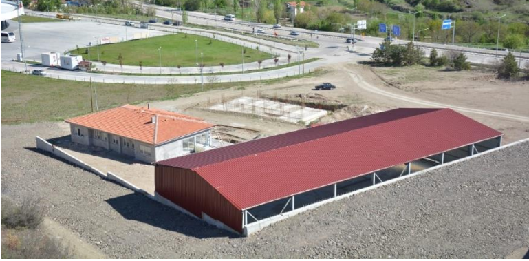
Yangın İlk Müdahale Ekip Binası
