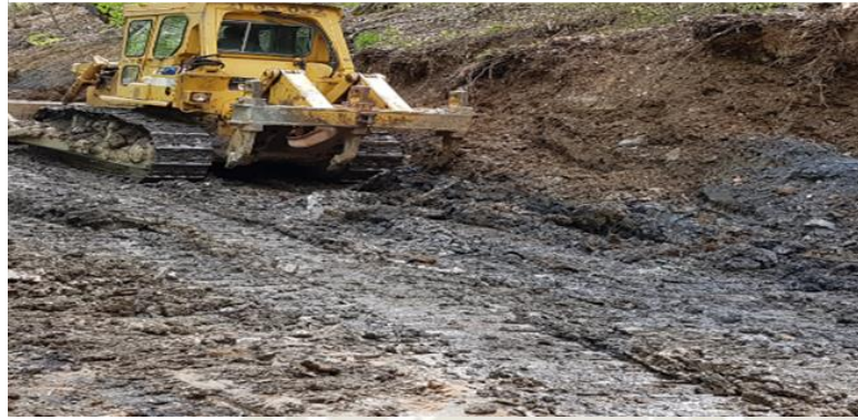
Yol Yapım Çalışmaları
